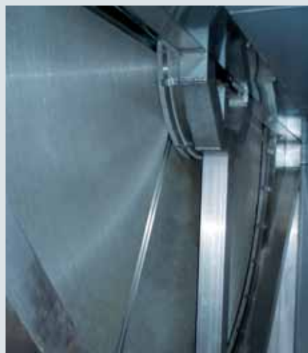
Снимок изнутри центральной установки, роторный теплообменник с рекуперацией влаги
