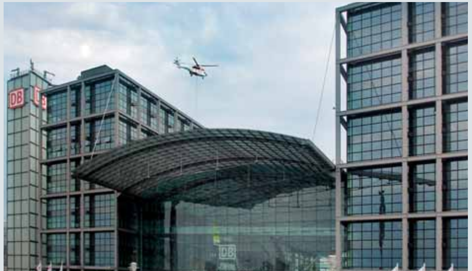
Вокзал Берлин — доставка центральных кондиционеров вертолетом
